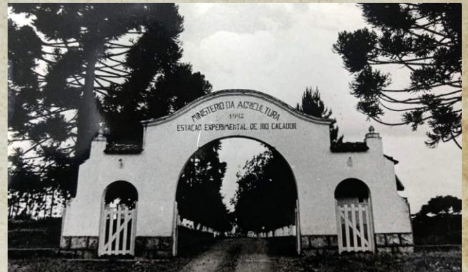
Portão de entrada para Epagri de Caçador, com data de 1943. Ministério da Agricultura / Estação Experimental do Rio Caçador - SC.
